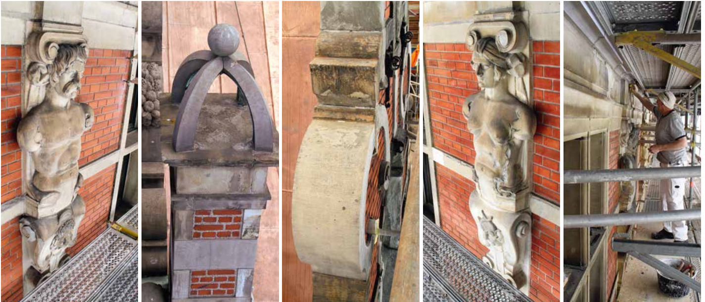
Stenhuggerne står for at reparere Børsens mange smukke former og figurer.
